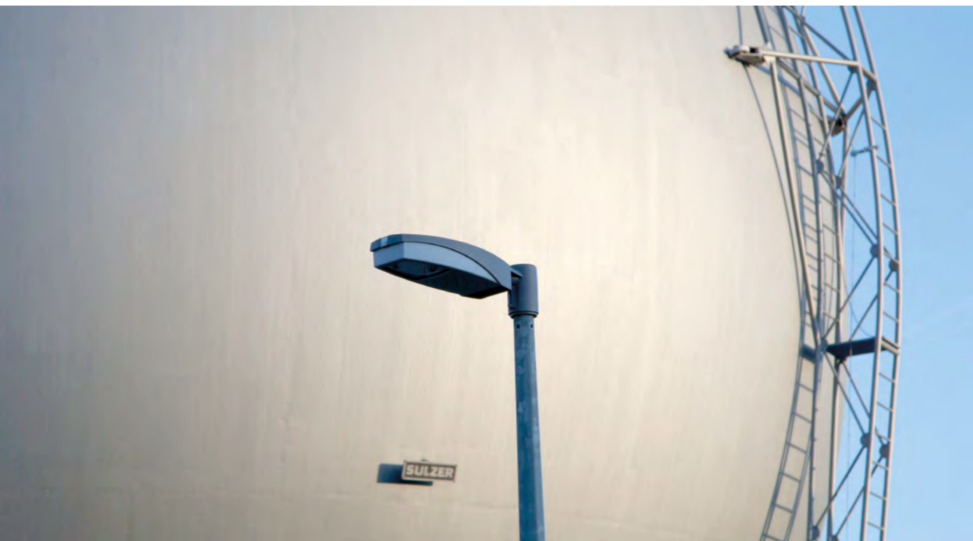
Sphère de stockage de gaz au Lignon ©Pierre Vallier
