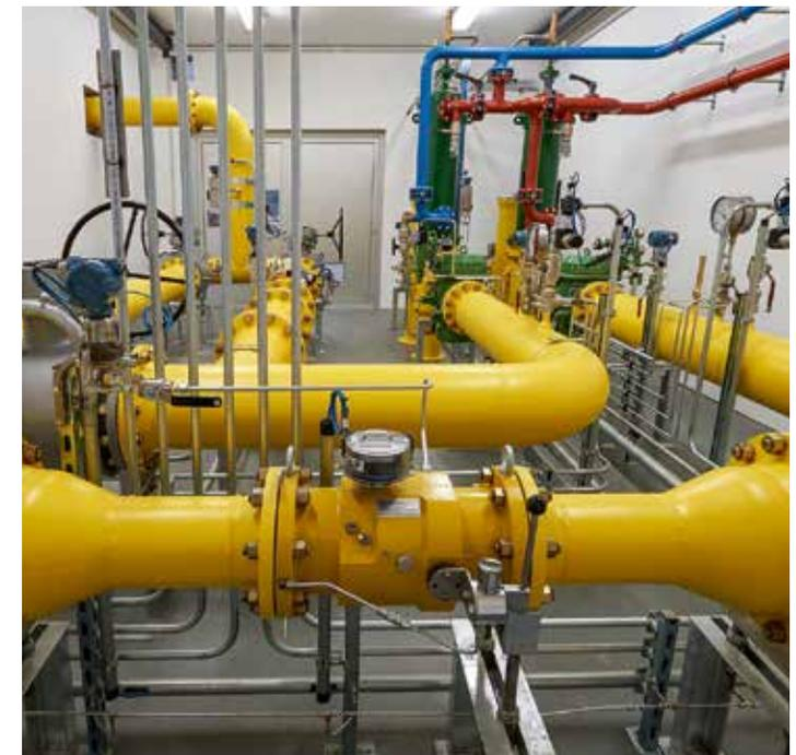
Les travaux pour augmenter la capacité du poste et le modifier, en vue d'assurer une redondance intégrale par deux lignes d'alimentation, ont été réalisés tout en assurant la continuité de l'alimentation du site industriel par la mise en place d'une installation mobile.
