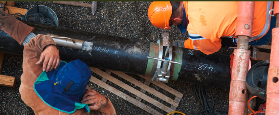
Préparation des tubes pour le soudage de la nouvelle section au tronçon existant.
