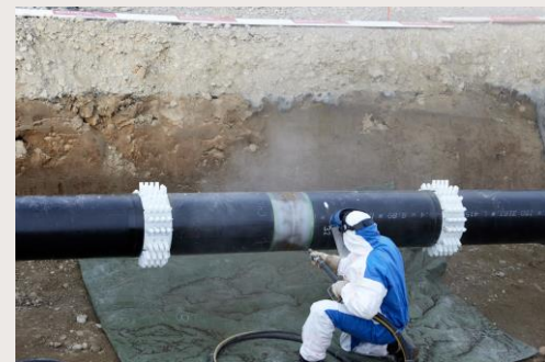
Insertion tube-dans-tube (sablage soudure 2 tronçons) Octobre 2021
