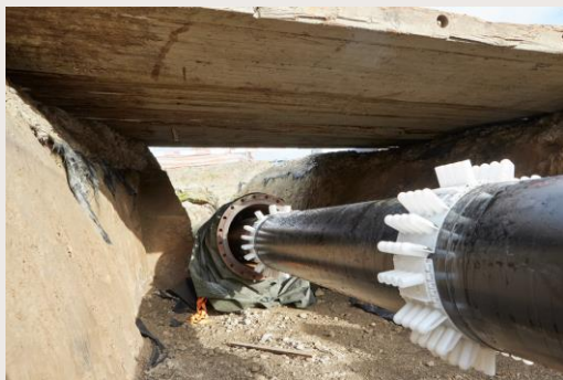
Insertion tube-dans-tube Octobre 2021
