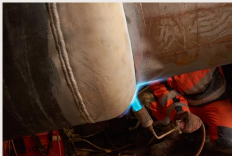
Travaux de soudure des manchons Février 2022
