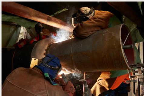
Travaux de soudure des manchons Février 2022
