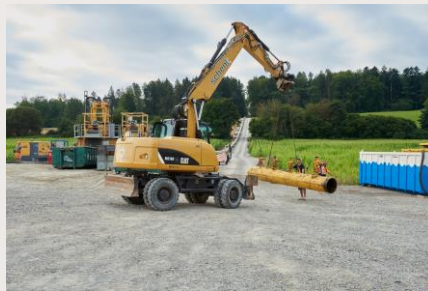
Gare d'essai pression hydrostatique Août 2021
