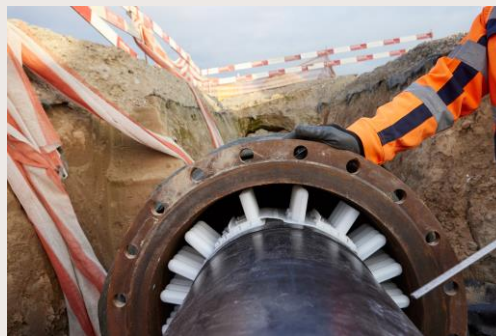
Insertion tube-dans-tube Octobre 2021
