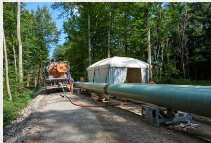
Essai hydrostatique Août 2021
