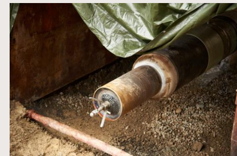
Travaux de soudure des manchons Février 2022
