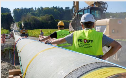
Insertion tube DN600 dans forage 13.09.2021
