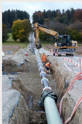
Insertion tube-dans-tube 26.10.2022
