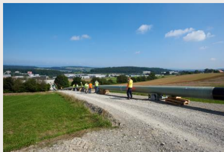
Préparation tube DN600 Août 2021
