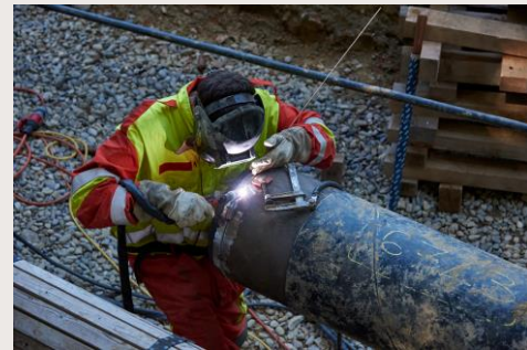
Soudure caps sur portion gazoduc abandonné 18 Mai 2022
