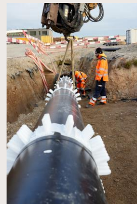
Insertion tube-dans-tube 26.10.2022
