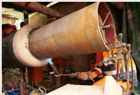
Travaux de soudure des manchons Février 2022
