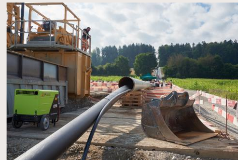
Lestage du tube avant insertion Août 2021
