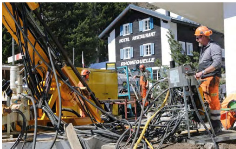
Forage de reconnaissance dans le Haut-Valais
