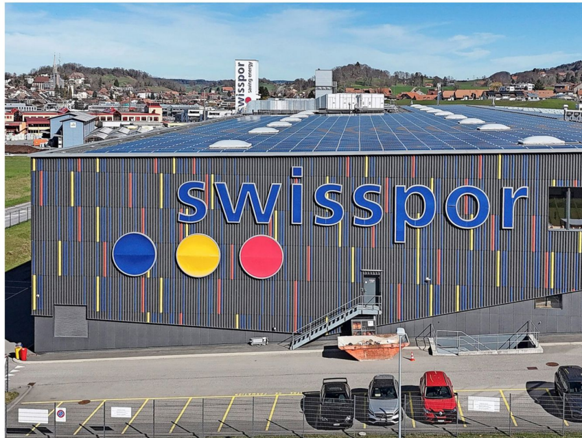
L'une des deux usines de Swisspor, à Châtel-Saint-Denis. Le responsable des sites romands du fabricant de matériaux d'isolation se prépare à annoncer, pour la fin avril, un relèvement de ses prix catalogue. Florian Cella
