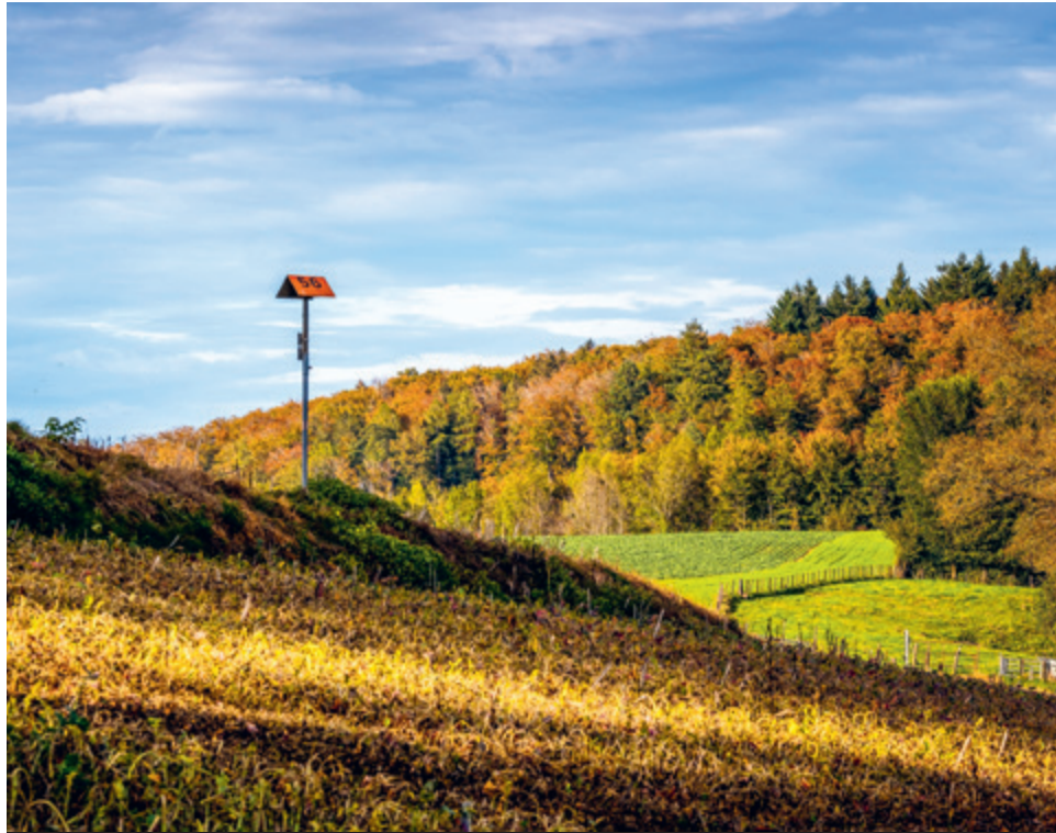
Balise gazière Gaznat, Bioley-Magnoux
